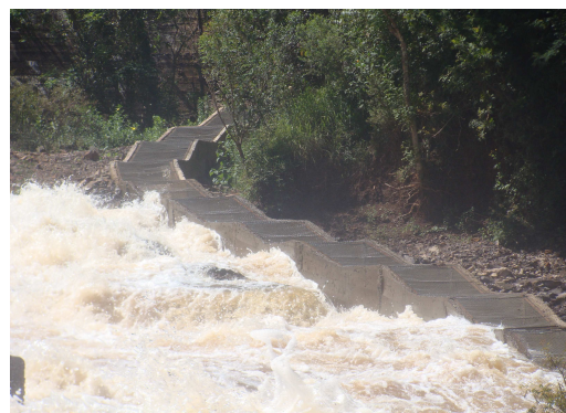
Escada para peixes junto a taipa da barragem Uhe Mata Cobra
