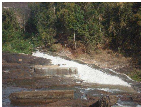
Escada para peixes junto a taipa da barragem Uhe Mata Cobra
